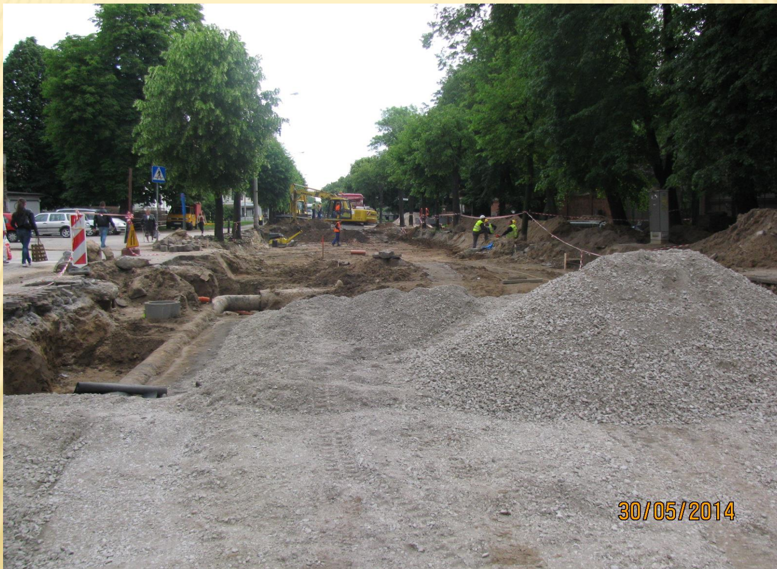
Prace obejmowały modernizację torowiska na linii nr 2 w kierunku OM Tarpno.
